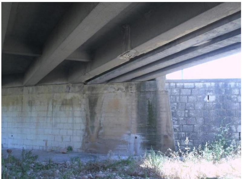
La luce netta è di 22.60 metri, l'altezza utile è di 3.30 metri, mentre lo spessore dell'impalcato è di 2.10 metri. (Tavola grafica DS\_02\_08\_02).
